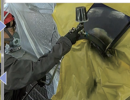
左リヤフェンダーのブラサフ塗装範囲を中心に、黒色のカラーブラサフを下から上に吹き付ける。口径は1.4mm。エア圧は0.17~0.18MPa、吐出量は全閉から4回転
